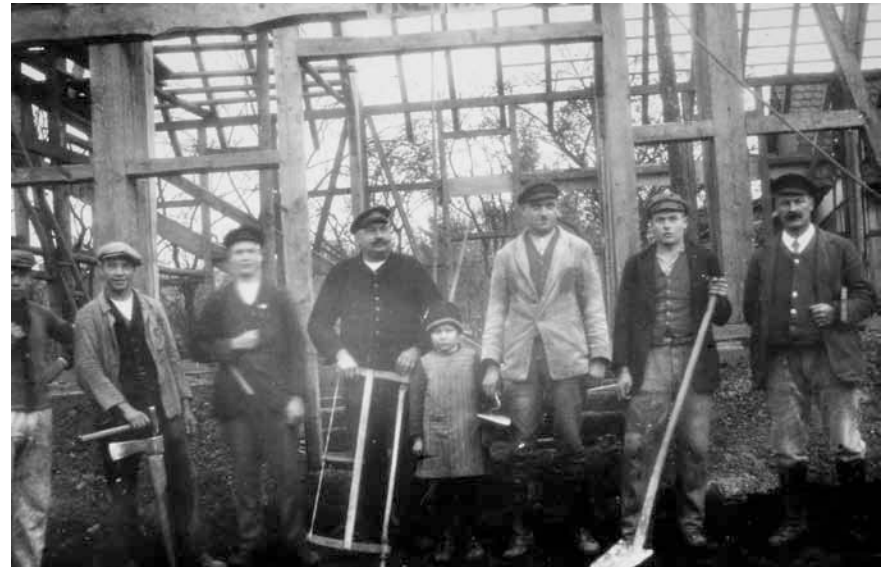
Der Bautrupp des Arbeiterturnvereins Flein beim Bau der Turnhalle; 1928.
